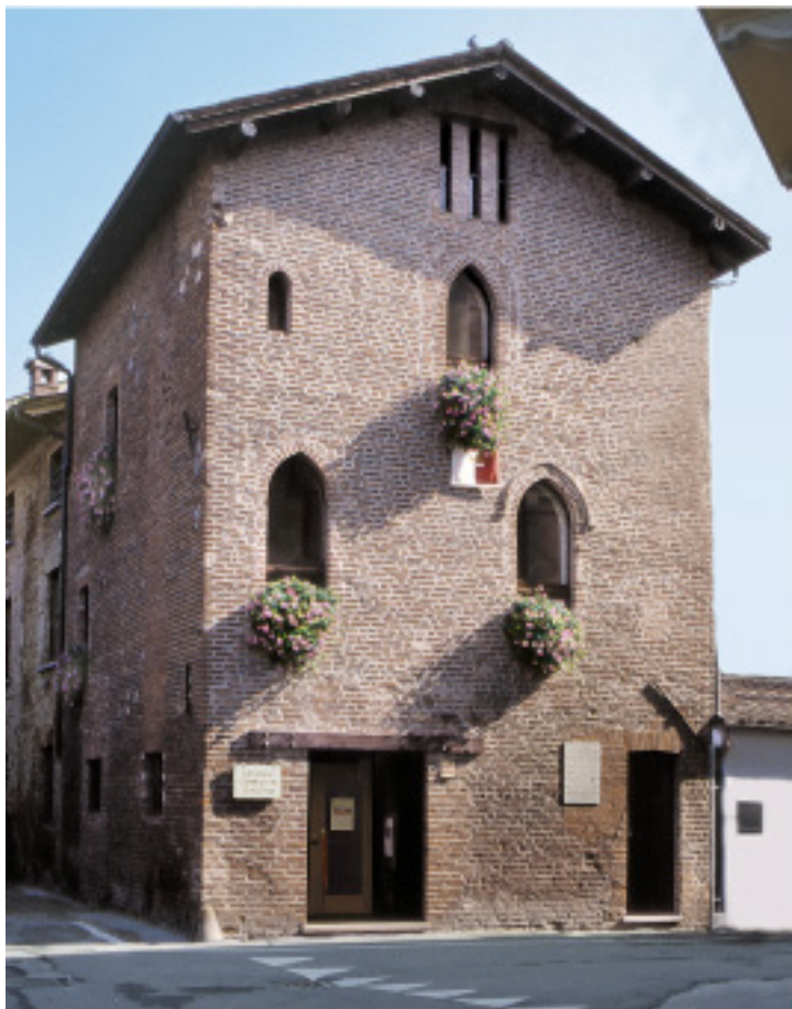
Fig. 5 - Il Museo della Stampa a lavori ultimati
